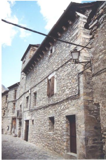
TORRE Y FACHADA CASA MORA
